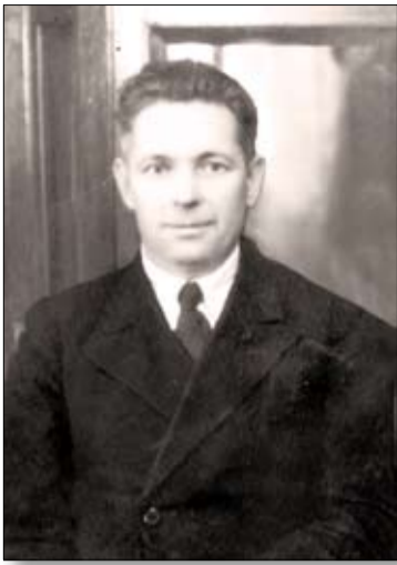
Н.М. Гальянов на Кыштымском медеэлектролитном заводе. 1940-е гг.
